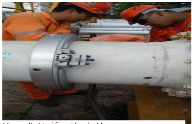
Figura 9 Verificación de Ductos
