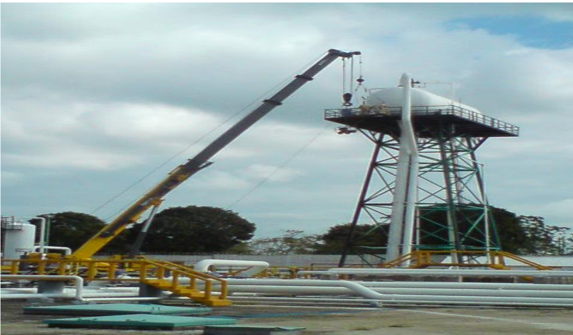
Figura. 15 Movimiento de maquinaria como grúas
