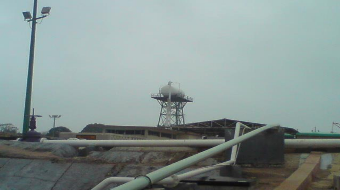
Figura 14. Tanque elevado de almacenamiento
