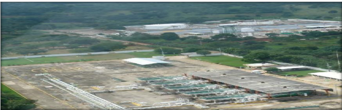
Figura 5 Instalaciones de la Batería
