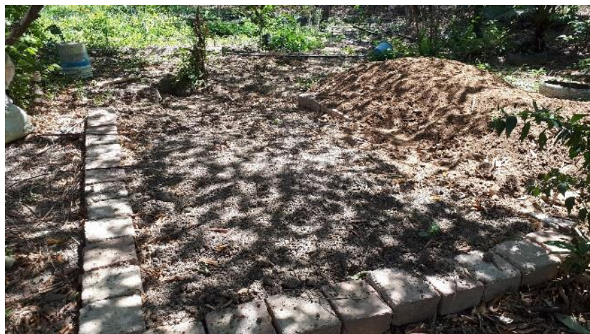
Figura 9. Acondicionamiento del terreno – fuente: Gómez, 2019
