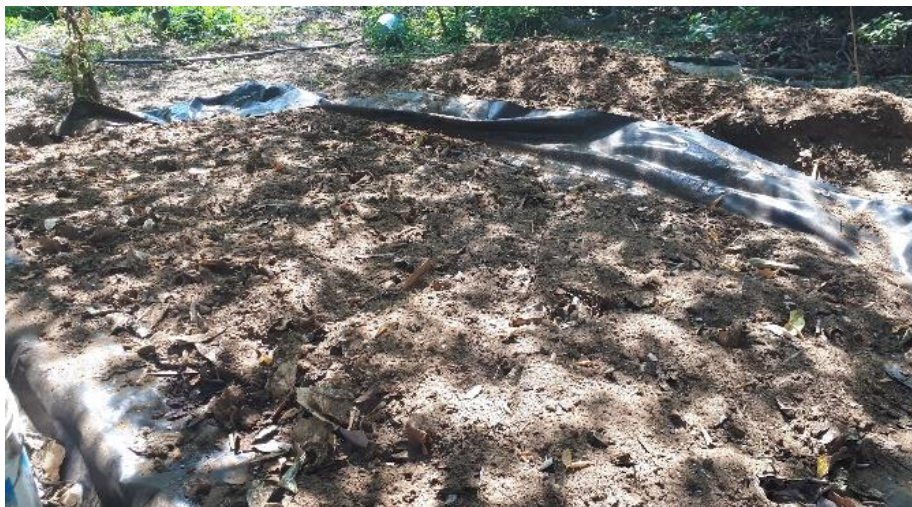
Figura 11. Colocación de primera capa de estiércol - fuente: Gómez, 2019
