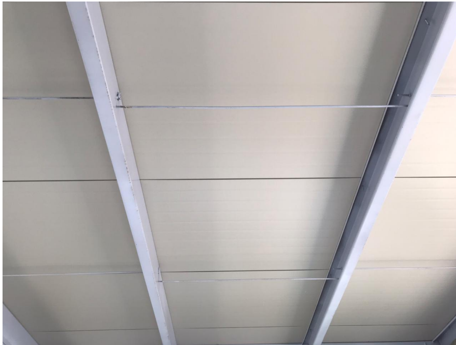
Ilustración 13. Vista interior del edificio techo multipanel.
