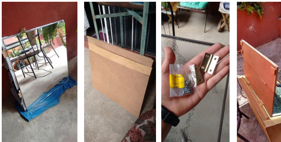
Figura 78. Estructura de cartón prensado y bisagras para los espejos.
