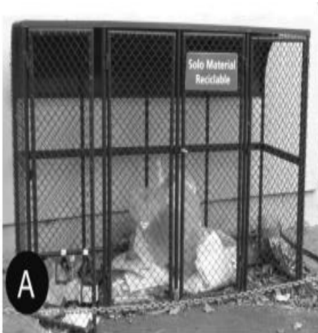
Figura 57. Diseño deficiente de almacén temporal debido a entradas pequeñas (Barrientos, 2011).
