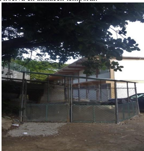
Figura 26. Almacén temporal después de la intervención.
