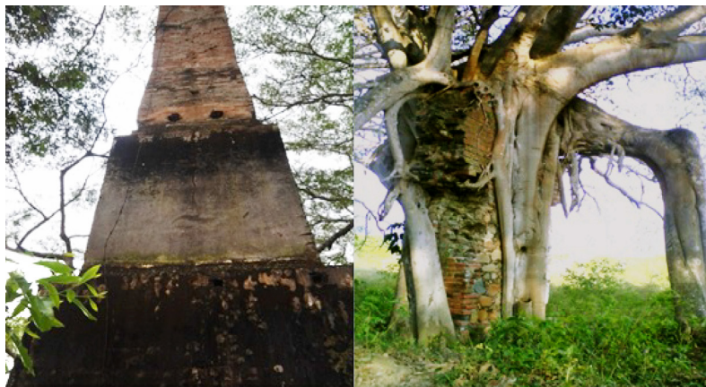
FIGURA 4 Ruinas de la finca Santa Lucía, ahora encontramos vegetación secundaria (Fotos: Azriel Ahbelenví)
