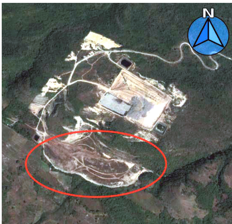
FIGURA 1 Zona clausurada del relleno sanitario.
