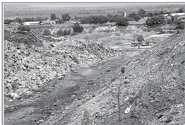
Figura 10 ■ | Zona de traslape entre celda 1 y 2.
