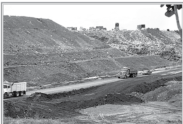
Figura 9 ■ | Talud concluido de celda 1 (lado izquierdo) y frente de trabajo en celda 2 (hacia el fondo).
