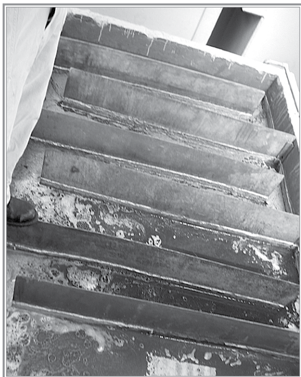
Figura 4 ■ | Tanque sedimentador provisto de mamparas.
