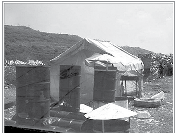
Figura 13 ■ Quemadores de biogas instalados en el RS de Tlalnepantla de Baz.
