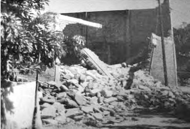
Figura 11. Daños en muros de mampostería confinada mal detallada (fotografía cortesía de Raúl Vera Noguez).
