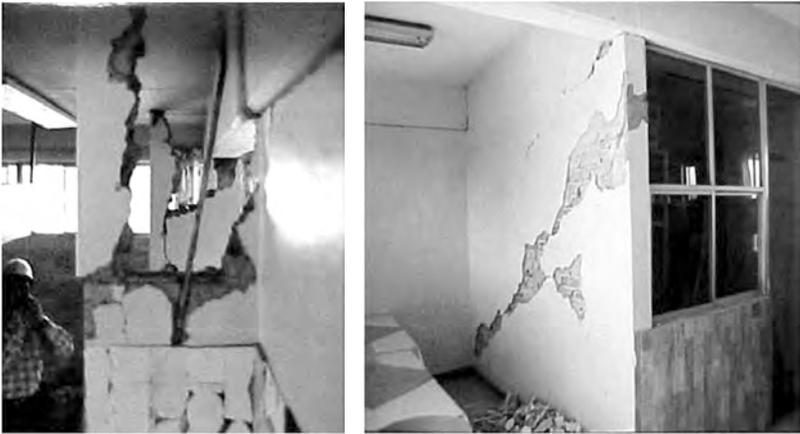
Figura 8. Daños en muros de mampostería, los cuales se vincularon indebidamente a la estructura (fotografía cortesía de Raúl Vera Noguez).
