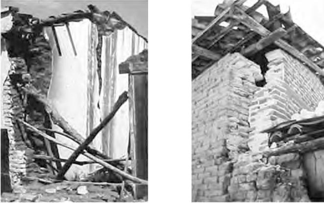
Figura 2b. Daños en estructuras de adobe donde la poca resistencia del material y el efecto del diafragma flexible causa daños muy importantes (fotografías cortesía de Raúl Vera Noguez).
