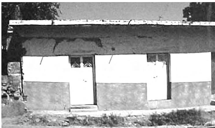
Figura 4. Grietas por flexión en muros de mampostería (fotografía cortesía de Raúl Vera Noguez).
