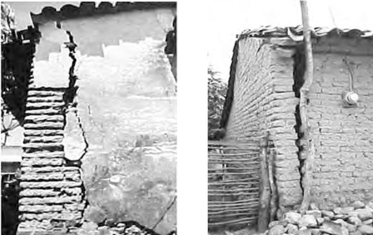
Figura 1a y b. Daños en estructuras de adobe donde la poca resistencia transversal y diafragma flexible generaron la separación de los muros (fotografías cortesía de Raúl Vera Noguez).
