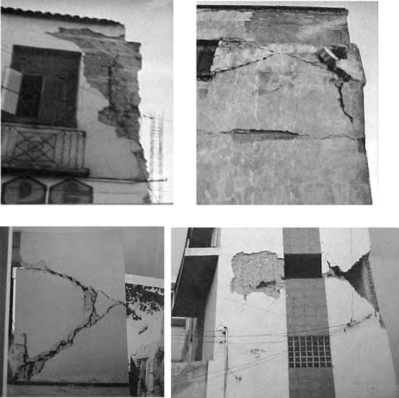
Figura 9. Daños en muros de mampostería sin refuerzo (fotografía cortesía de Raúl Vera Noguez).
