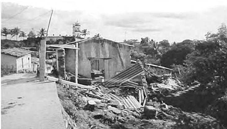
Figura 3. Colapso de estructura por no considerar las condiciones naturales del terreno al momento de diseñar la cimentación (fotografía cortesía de Raúl Vera Noguez).
