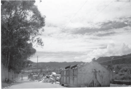
Figura 2. Contenedor metálico para una fuente de alta generación (panteón mpal. SCLC).
