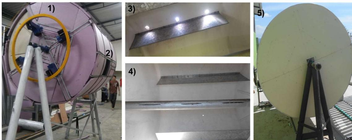
**Figura 4.4** Proceso de construcción de la cámara de secado rotatoria, 1) Encapsulamiento de la cámara rotatoria con metal y recubrimiento aislamiento térmico,
