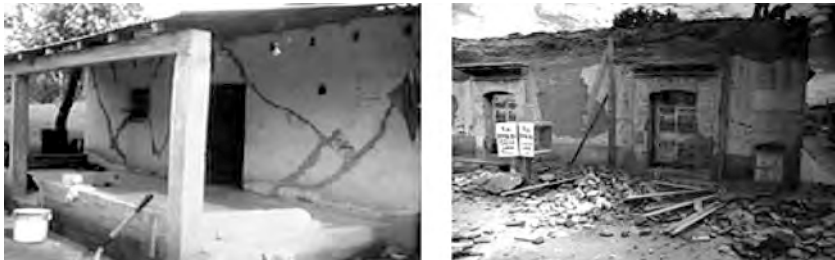
Figura 15. Vivienda rural de adobe dañada por sismo 30 de septiembre de 1999. [3]
