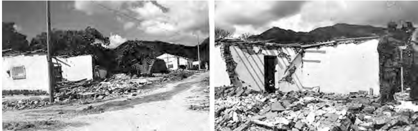
Figura 12. Daños en estructuras de adobe en el sismo del 20 de octubre de 1995 en Villaflores, Chiapas. [18]
