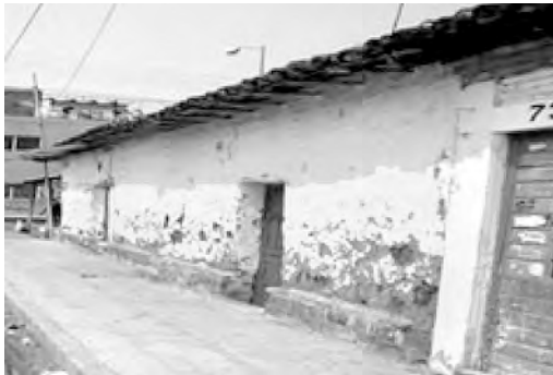
Figura 8. Construcción típica de adobe en el centro histórico de Tuxtla Gutiérrez, Chiapas con espesor considerable de los muros, la cubierta es pesada, falta de mantenimiento y algunas reparaciones hechas con tabique de barro e incrustaciones de elementos de concreto.
