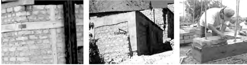
Figura 22. (a) Refuerzo de muros de adobe con madera en Colombia (Cardona y otros, 2004), (b) Vivienda de adobe rehabilitada con aplanado de mortero sobre malla electrosoldada que resistió sin daños el sismo de Arequipa (Zegarra y otros, 2001) y (c) Refuerzo interior de caña en viviendas de adobe en Perú. [31]
