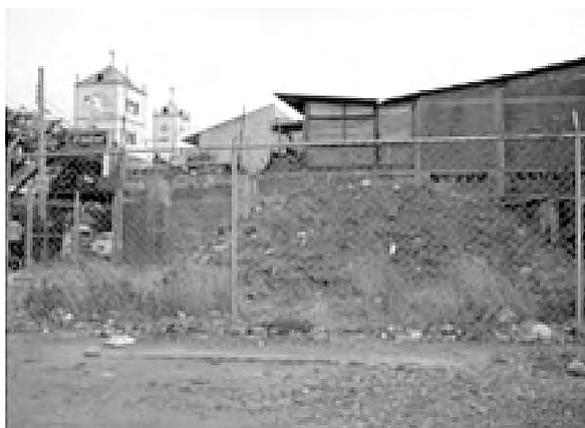
Figura 2. Demolición en los años 2007 y 2006 de dos viviendas con dos y un niveles respectivamente, con estructuras de adobe, ubicadas en el centro histórico de Tuxtla Gutiérrez, Chiapas.
