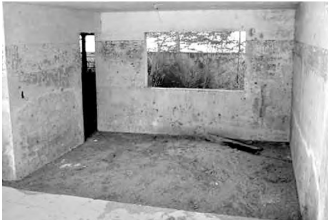
Foto 10. Interior de una residencia abandonada en La Esmeralda. El agua alcanzó una altura superior a los 2 m.
