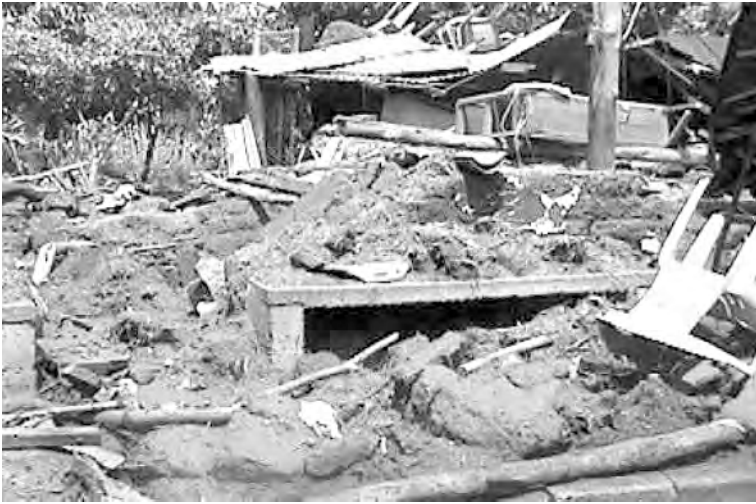
Foto 9, Tuxtla Gutiérrez, vivienda de adobe completamente destruida por la inundación de 6 de octubre de 2003 (Fuente: Subsecretaría de Protección Civil)
