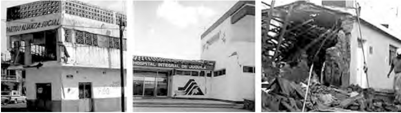
Figura 16. Colapso de estructuras de mampostería no reforzada y adobe, que adicionalmente presentan irregularidades. [21 y 22]
