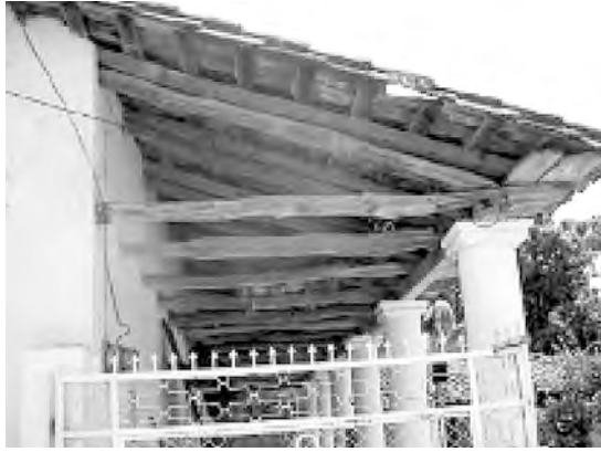
Figura 11. Cubierta con armaduras de madera y teja de barro típica de viviendas de adobe de Chiapa de Corzo y Tuxtla Gutiérrez. [14]
