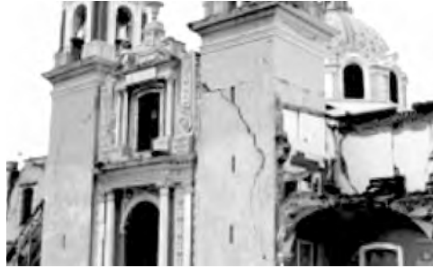
Figura 14. Iglesia de la Señora de los Remedios en el estado de Puebla dañada de manera importante por el sismo de Tehuacán en 1999 [4] .
