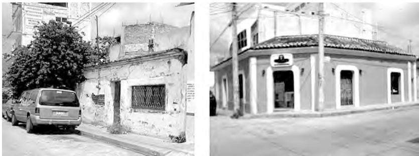
Figura 19. Viviendas de adobe ubicadas en Tuxtla Gutiérrez, Chiapas y que presentan distinto nivel de vulnerabilidad de acuerdo con la metodología de la UAM, A y B, respectivamente.
