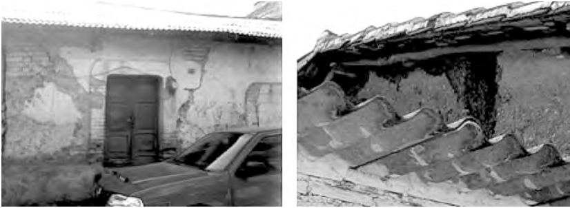
Figura 17. Patologías típicas en viviendas de adobe en Tuxtla Gutiérrez, Chiapas: poco mantenimiento del sistema, mala calidad del material, falta de recubrimiento y protección de muros y peso excesivo en cubierta.
