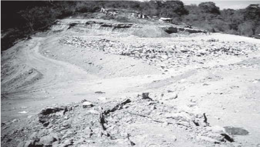
Foto 10. Trabajos de conformación del sitio.
