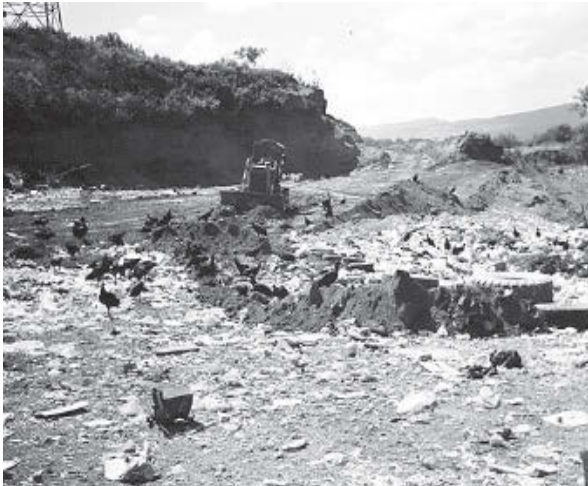
Foto 6. Delimitación del área de trabajo y cobertura de los residuos
