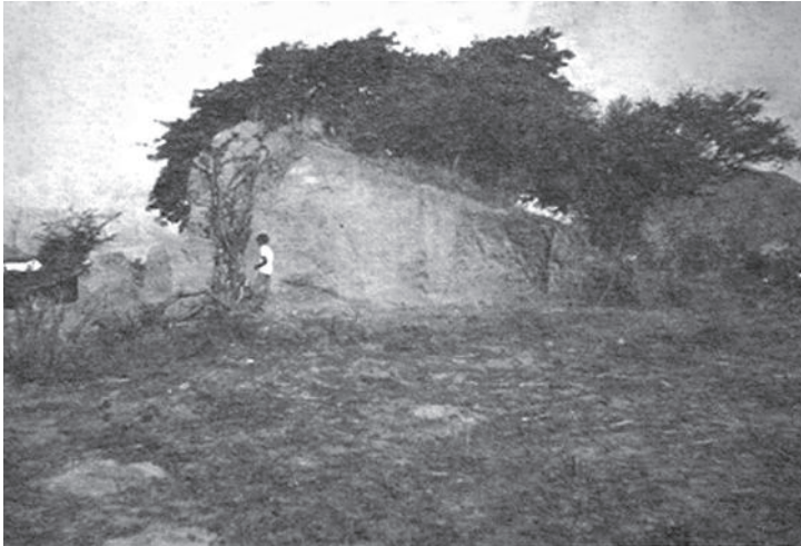
Figura 8. Vista oeste del Montículo 1 en 1974. Nótese el avanzado deterioro y destrucción ocasionados por los ladrilleros (cf. fotografía tomada en 1968, fig. 4).
